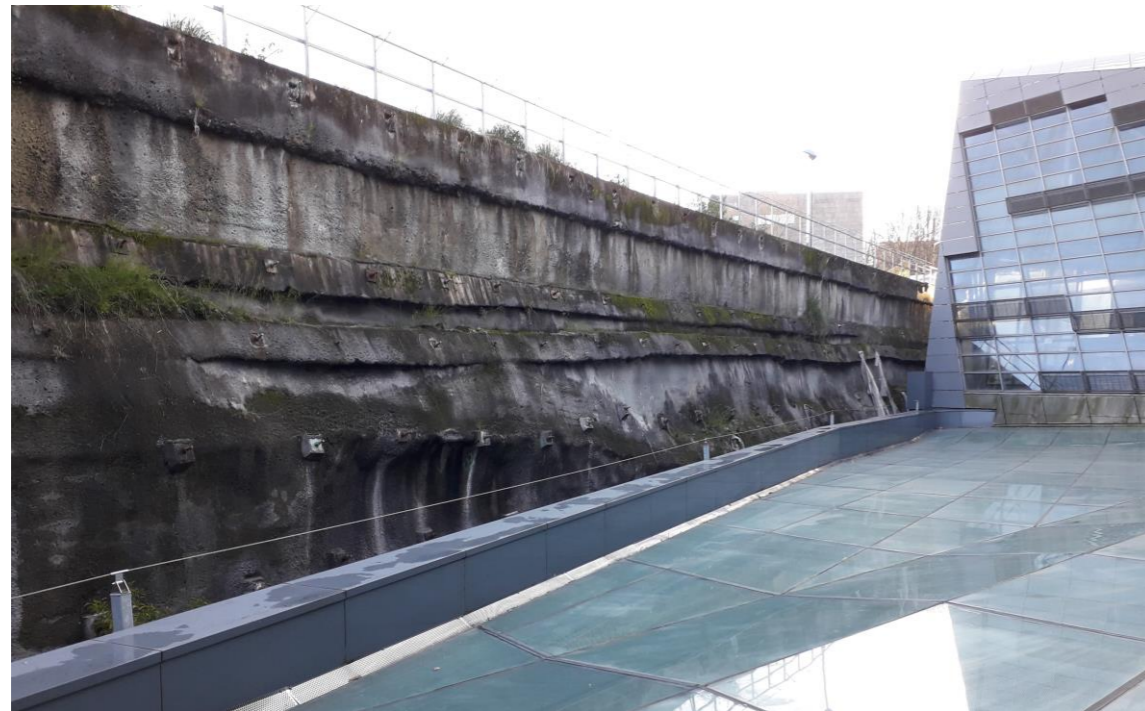
Figura 4. Vista actual del muro provisional
