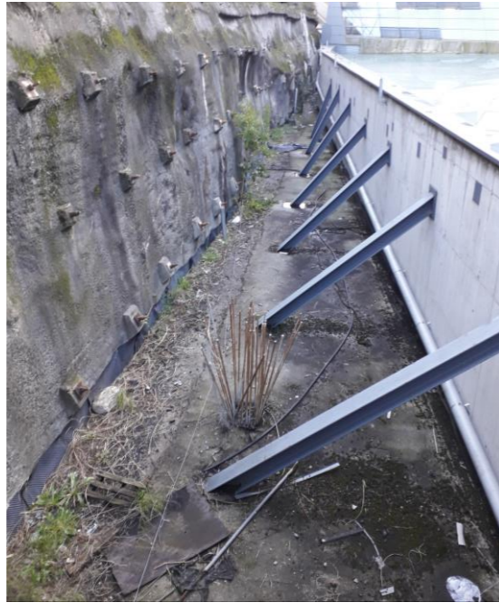
Figura 6. Foso actual entre muros
