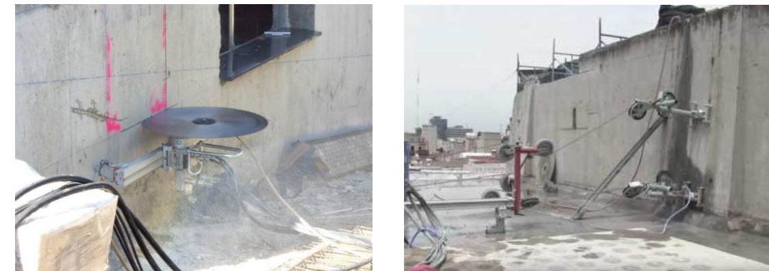
Figura 16.- Corte con disco (izq) y corte con hilo (dcha)
