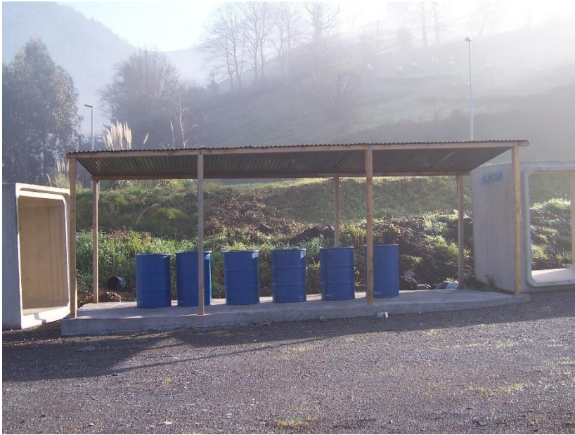
Figura 3 Punto limpio en construcción
