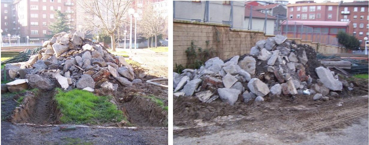
Figura 4 Acopio de residuos de construcción y demolición
