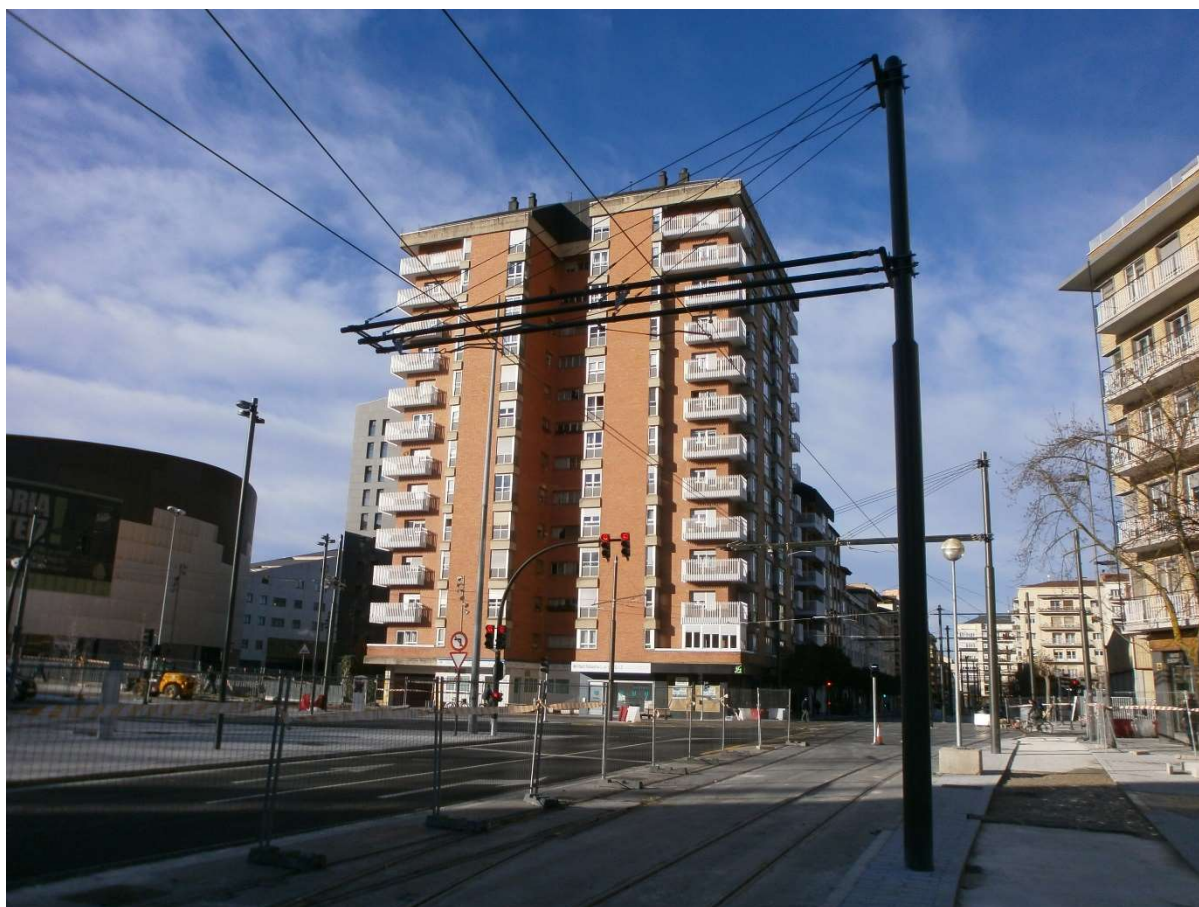
Figura 6. Vista de triple ménsula. Las tres ménsulas están bloqueadas (izquierda de la imagen).
