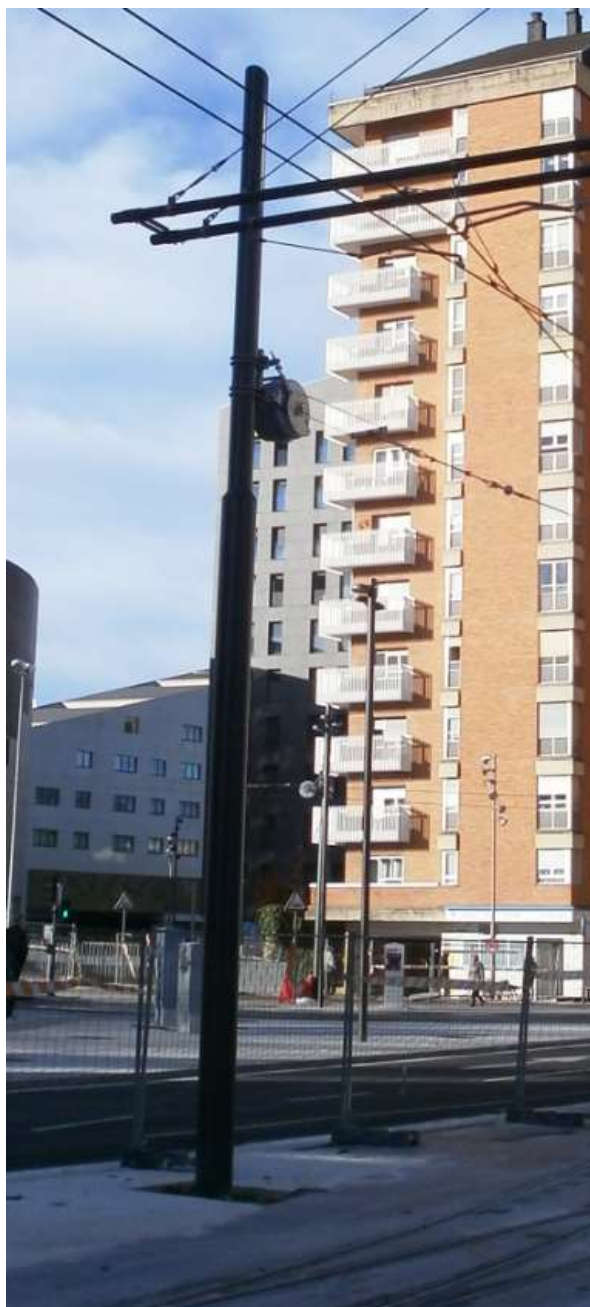
Figura 4. Extremo compensado para vía derecha en PK 1+302
