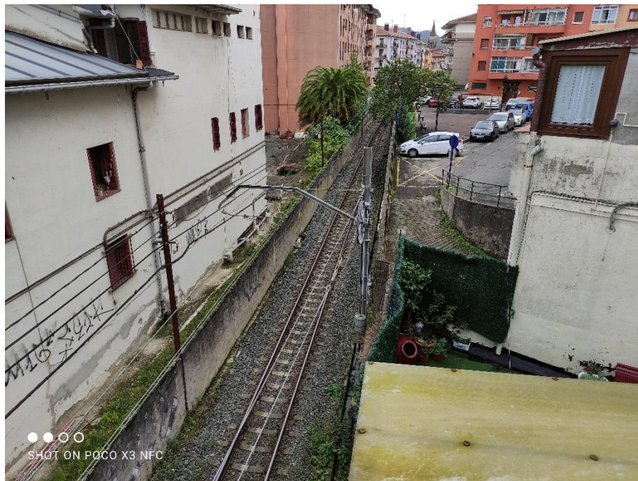
Fotografía 18. Poste de anclaje lado Errenteria
