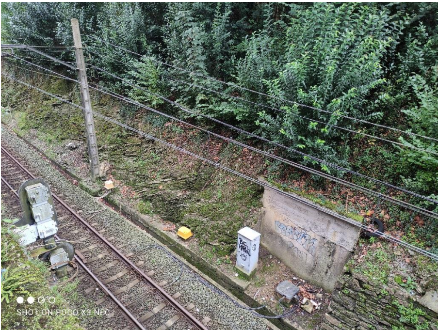
Fotografía 12. Postes de catenaria de hormigón con tendido aéreo de catenaria (2 ud)
