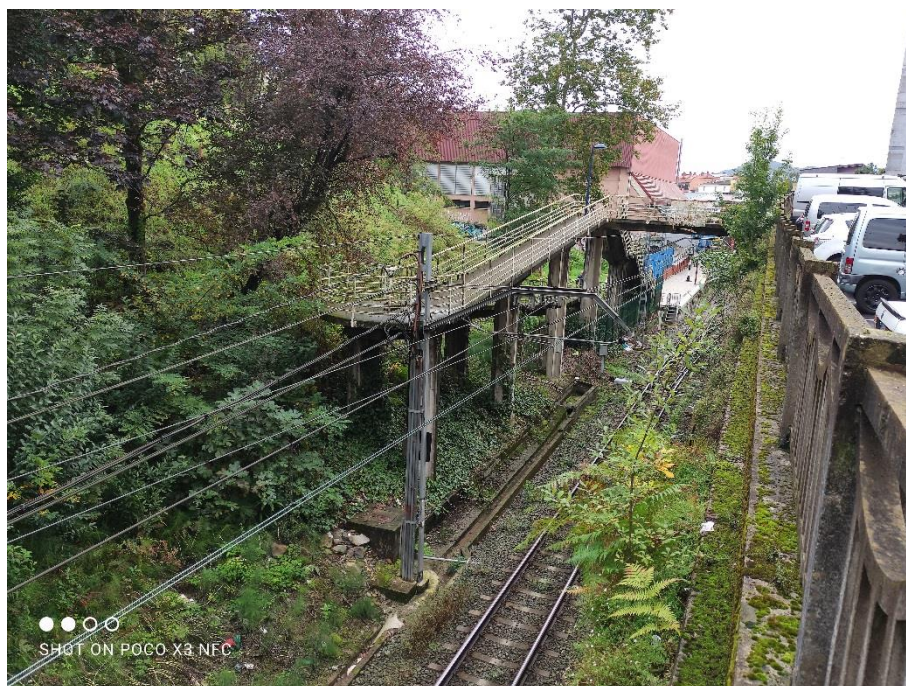
Fotografía 14. Poste de elevación con anclaje para entronque red 3 kV
