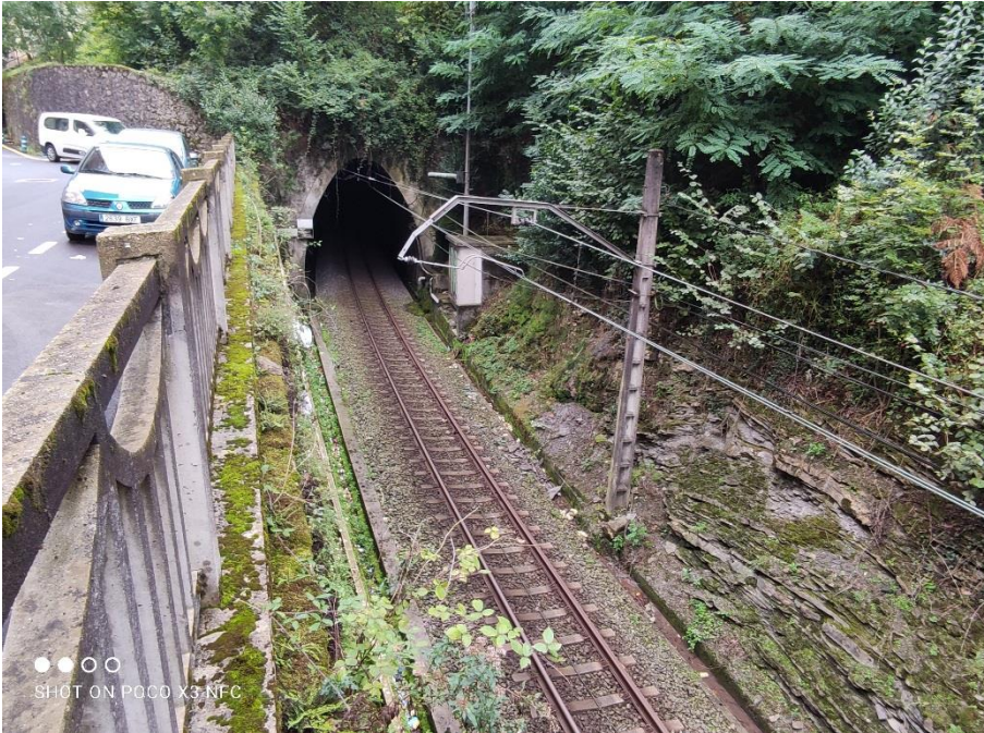
Fotografía 11. Boca túnel existente en vía única
