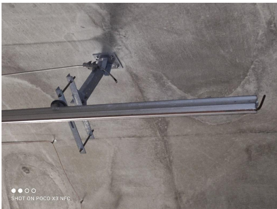
Fotografía 3. Fin catenaria rígida Altza
