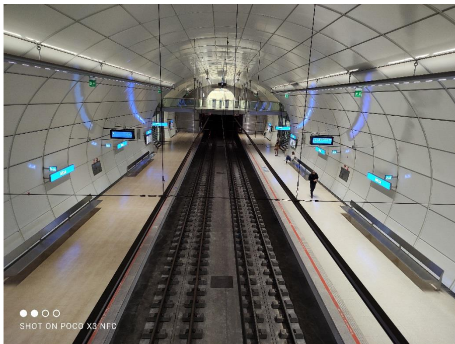
Fotografía 1. Estación de Altza
