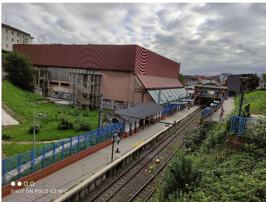
Fotografía 16. Semipórticos 2 vías (3 uds)
