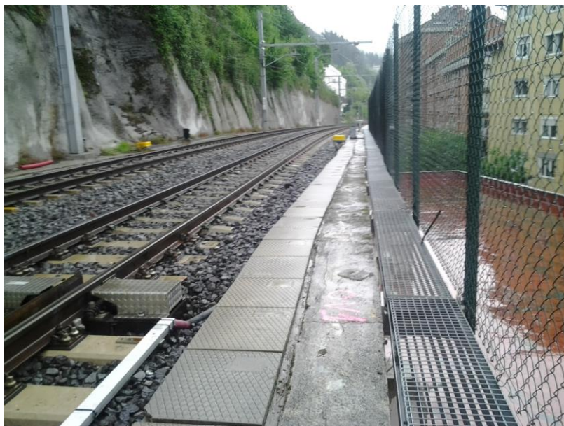
Estado actual del talud existente del Euskotren
