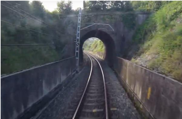
Vista desde la vía en avance de PPKK del paso superior en el PK 72+368 sobre el que el camino de acceso al Barrio Itsaspe cruza sobre la plataforma ferroviaria.
