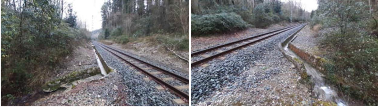
Vistas de las cunetas de margen izquierda (imagen de la izquierda) y margen derecha (imagen de la derecha) de la plataforma de vía actual y el punto en el que abandonan la traza vertiendo al terreno natural y al cauce del arroyo Urtzabale en torno al PK 72+800.
