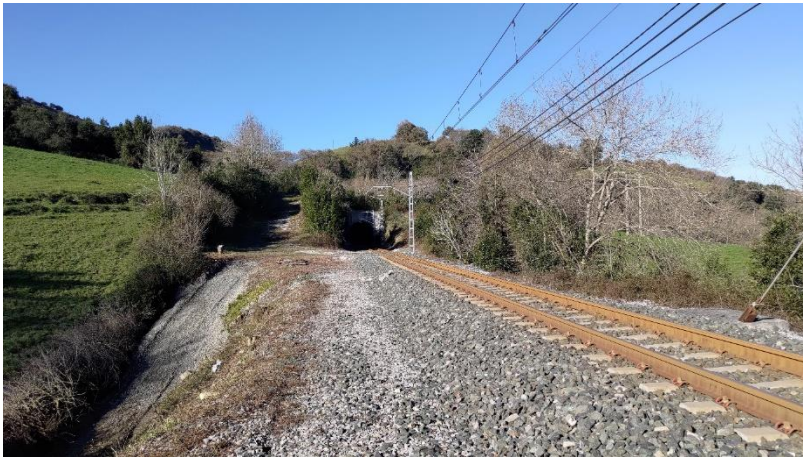
Vista del camino de acceso a la plataforma y del camino de bajada hasta el cauce del arroyo Urtzabale en la margen derecha de la traza. Imagen tomada hacia PPKK decrecientes desde el PK.
