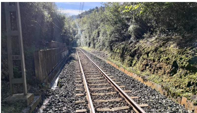
Imagen representativa de la sección tipo de plataforma en trinchera con taludes a ambos lados provista de bermas y cunetas laterales (PK 72+810 a PK 73+181)
