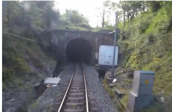
Vista desde la vía en avance de PPKK de la boca del túnel Sagarbide en el PK 73+187.
