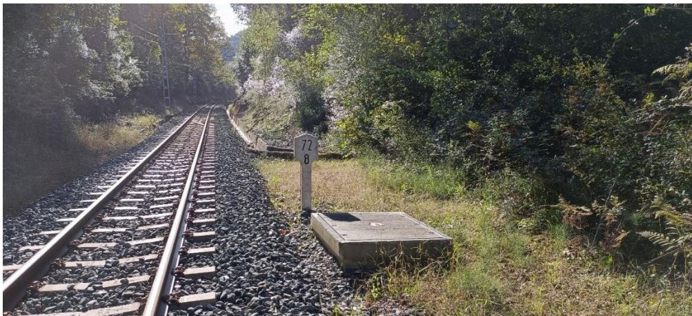
Punto de vertido de las cunetas en proximidades del PK 72+800. Arqueta de comunicaciones en margen derecha de la vía.
