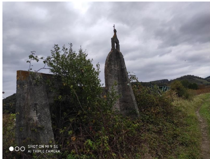
Figura 1. Fachada situada junto camino sobre la estación del ferrocarril
