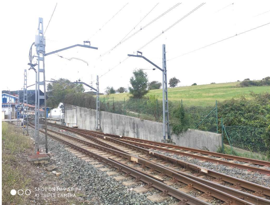
Figura 3. Plataforma de doble vía sobre balasto con escape ferroviario entre vía 1 y vía 2 y vía mango existente a la entrada dela estación desde lado Bilbao.
