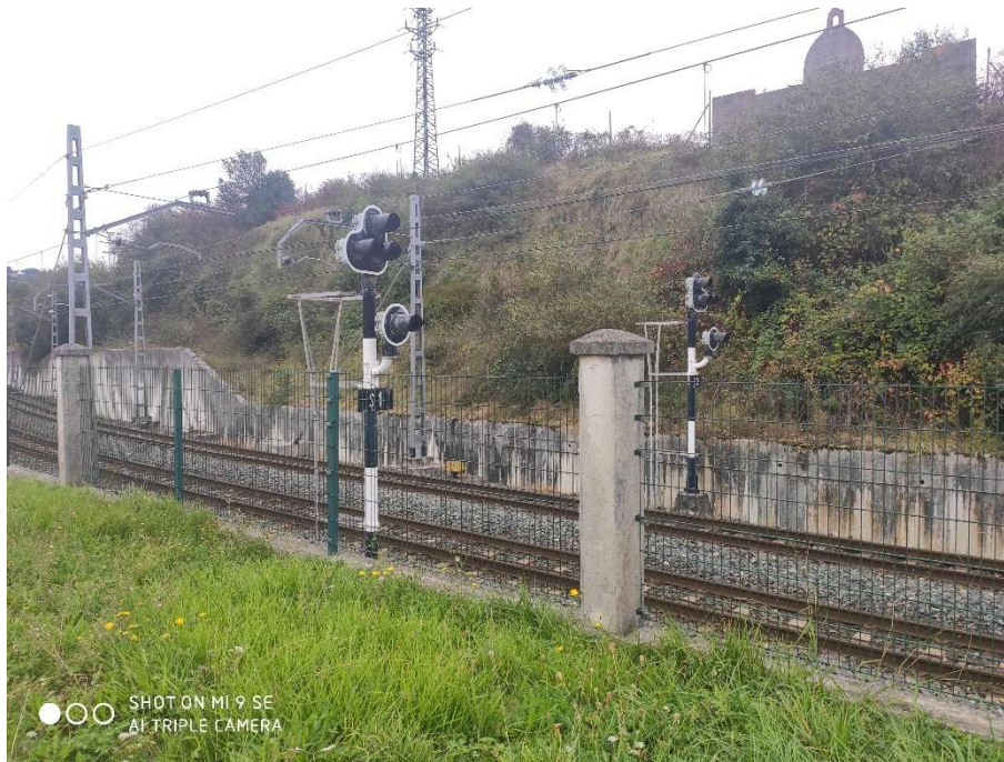
Figura 2. Plataforma de doble vía en balasto entre edificio de cocheras de autobuses de Euskotren y estación de ferrocarril de Zumaia, con elemento ornamental existente al fondo, sobre la ladera del monte Basusta.
