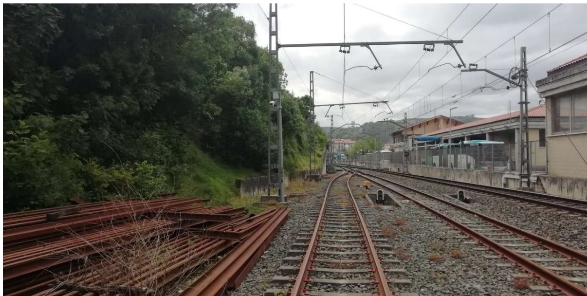
Figura 4. Plataforma de vía única con dos vías apartadero existentes, donde se ubicará la playa de vías a cocheras de trenes
