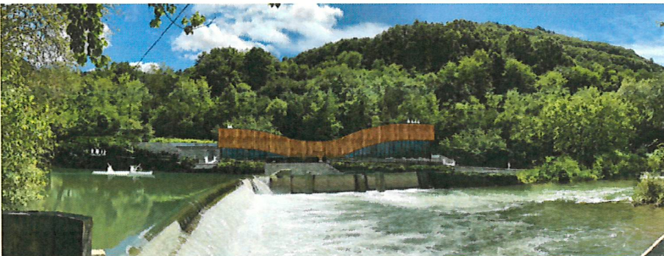
Imágenes 2 y 3. Estado actual de la zona, con el edificio abandonado de la central (arriba) e infografía de la propuesta de edificio (abajo).
