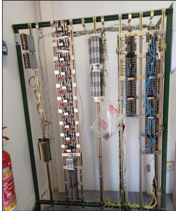
*Figura 7: Repartidor abierto 10C y 3C de la estación de Usurbil*
