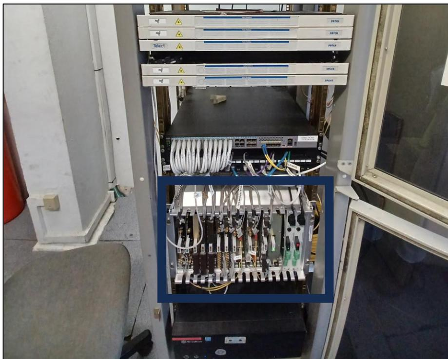
Figura 9: Equipamiento PDH en la estación de Usurbil
