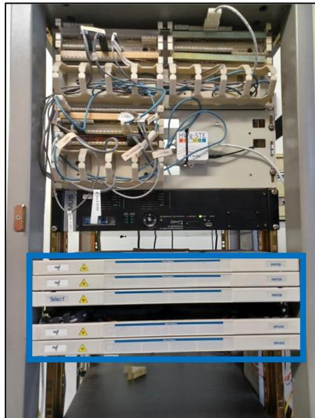
*Figura 3: Bandejas del repartidor de F.O. en la estación de Usurbil*
