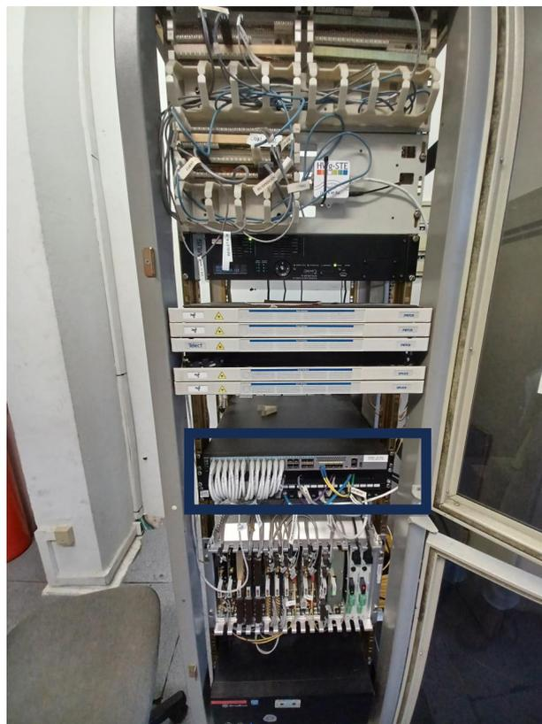
Figura 12: Switch IP principal de la estación actual de Usurbil
