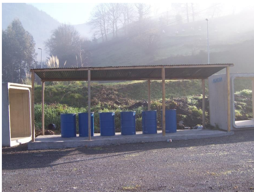
Punto limpio en construcción
