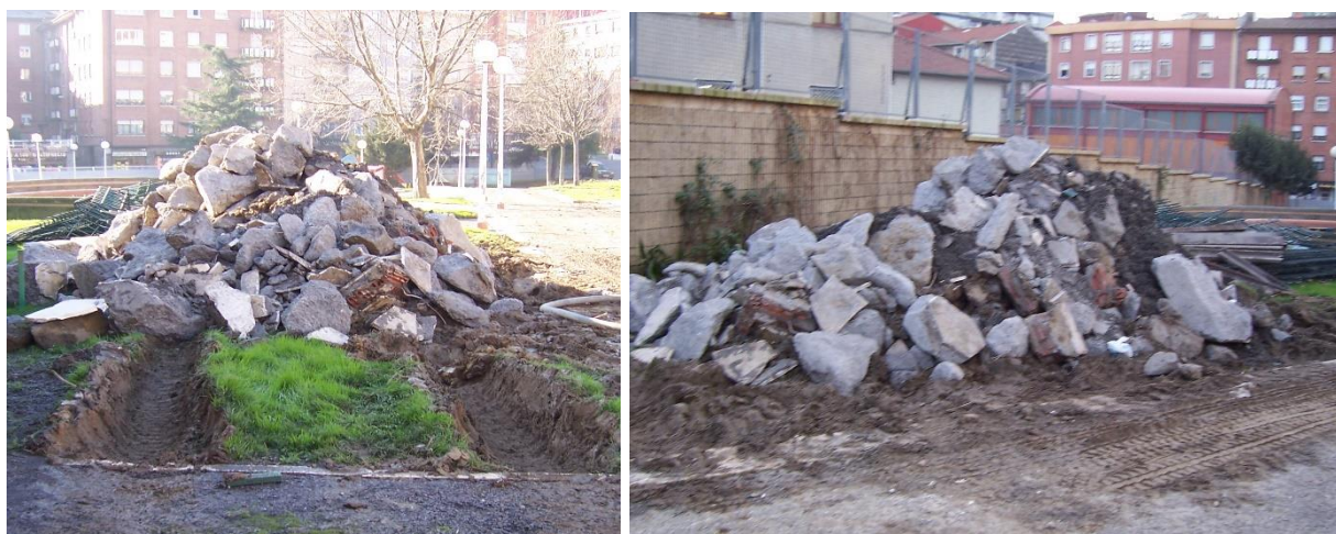
Acopio de residuos de construcción y demolición
