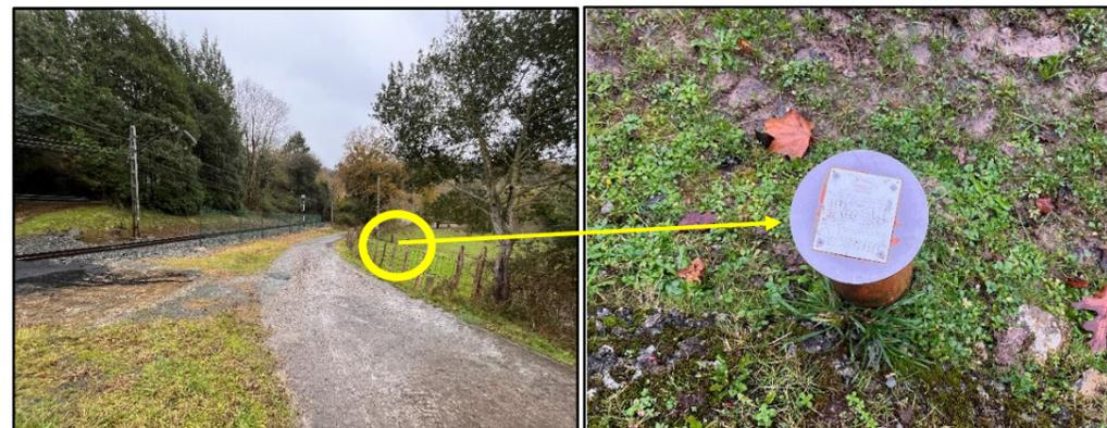
FIGURA 1. TAPÓN REGISTRO DE LA TUBERÍA DE ABASTECIMIENTO DE LA ZONA. (FUENTE: ESTEYCO)
