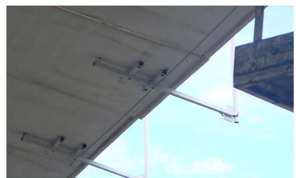
EJEMPLO DE COLOCACIÓN DE SISTEMA MIXTO ANTICAÍDAS
