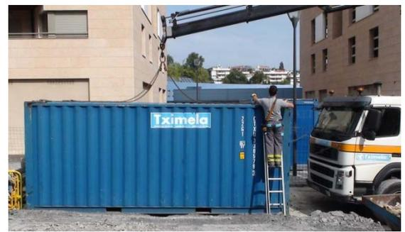
No permanecer en ningún momento bajo la caseta cuando ésta esté suspendida ni dentro del radio de acción de la carga, utilizando sistemas guía para conducir la caseta hasta su zona de colocación.
