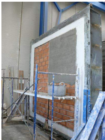
Figura 2.9 – Aplicación de revestimiento de mortero
