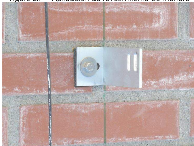
Figura 2.10 – Anclaje atornillado sobre el ladrillo caravista
