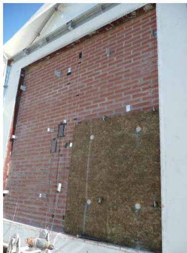
Figura 2.11 – Paneles de lana de roca sobre ladrillo caravista
