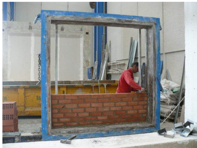
Figura 2.2 – Construcción de la muestra: muro de doble hoja de fábrica de ladrillo
