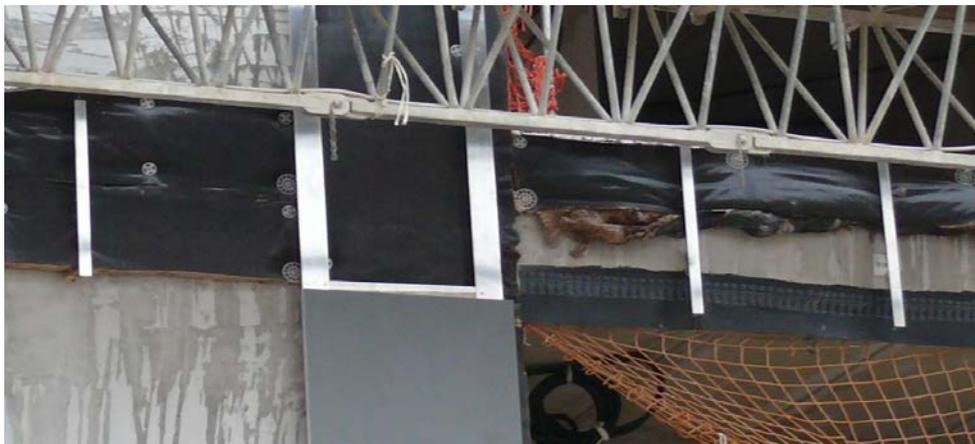
*En casos como el de la imagen, es necesario sustituir las mantas en aquellos puntos que no pueda garantizarse el correcto funcionamiento de la solución constructiva original de proyecto.*
