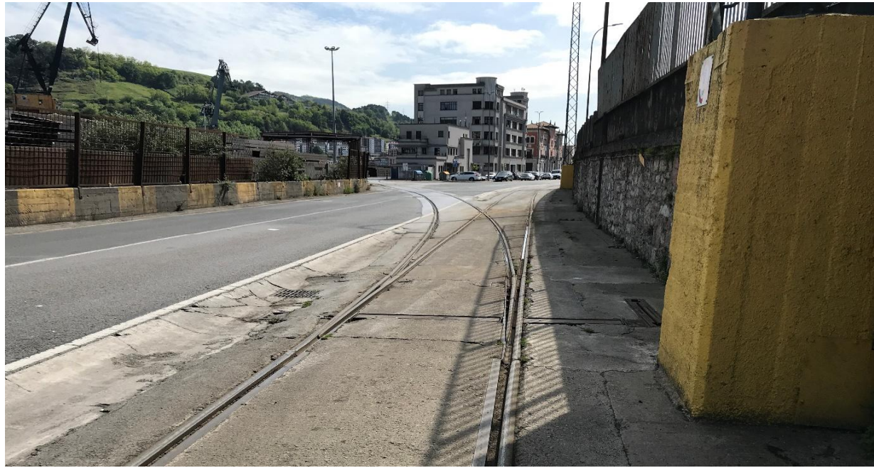
FIGURA 9. LUMINARIA AFECTADA EN EL AMBITO DEL DESVÍO 4
