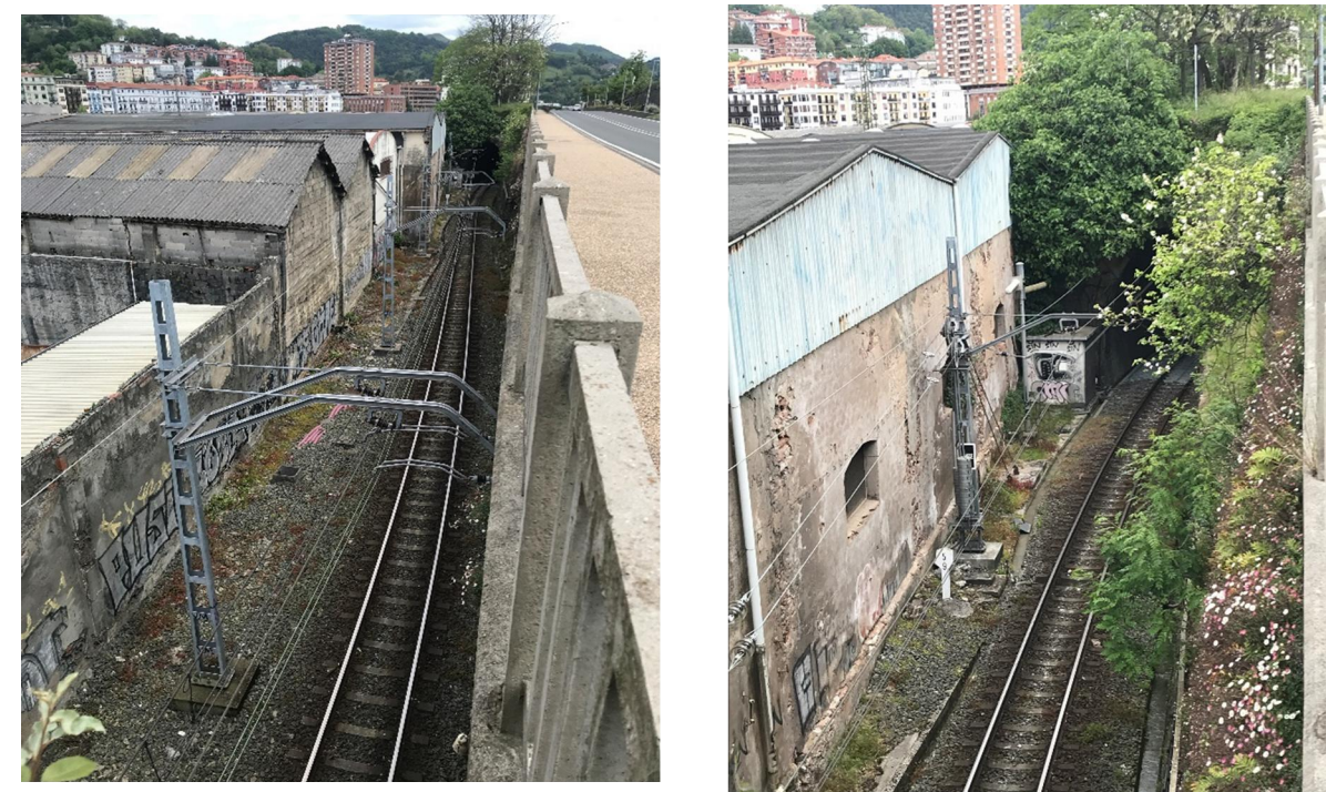
FIGURA 5. INSTALACIONES EXISTENTES EN ZONA DE CONEXION
