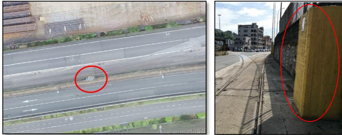
FIGURA 1. Cruce con la torreta en el P.K 0+810 en la vía triple
