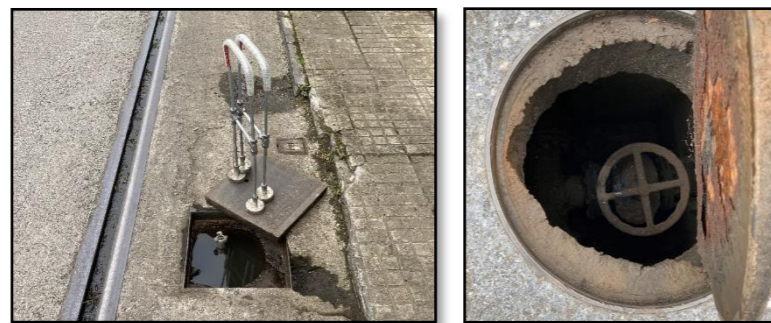
FIGURA 3. Izquierda. Acometida (PK 0+210, ANCHO TRIPLE: VÍA ALGEPOSA) FIGURA 4. Derecha. Canalización de abastecimiento con profundidad superior a 0,5 m
