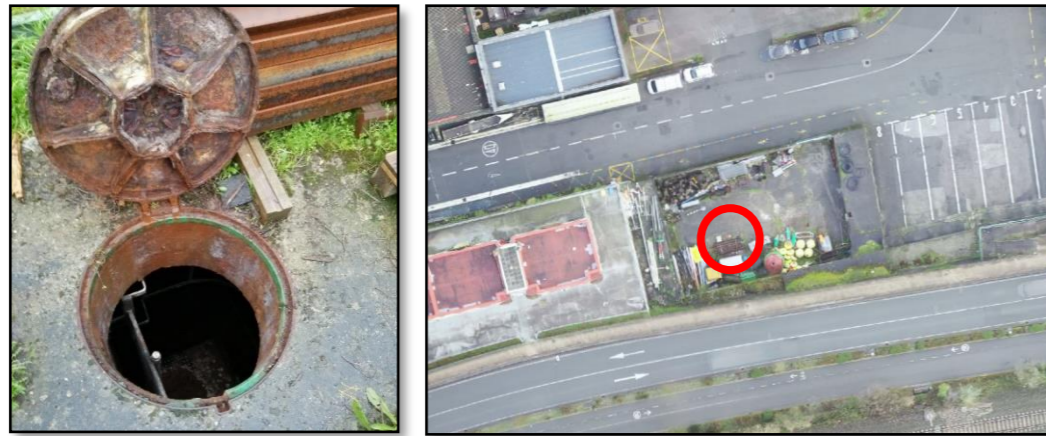
FIGURA 5. Pozo túnel de fecales
