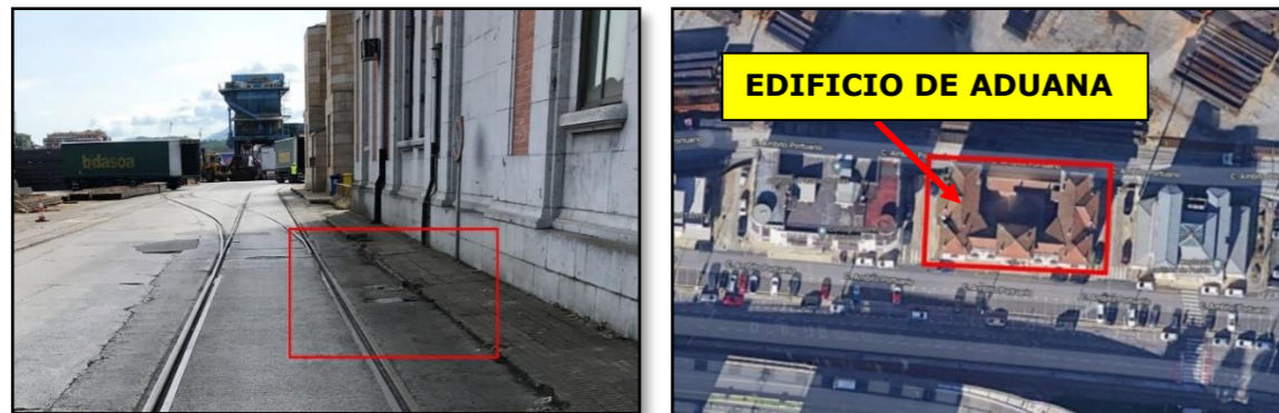
FIGURA 2. Cruce con la acometida (PK 0+210, ANCHO TRIPLE: VÍA ALGEPOSA)
