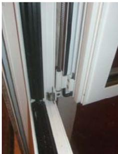
La estanqueidad o hermeticidad de una ventana es importante desde el punto de vista del aislamiento acústico, y está influida por el diseño de perfilería, sistema de apertura, puntos de cierre, herraje, juntas de estanqueidad, ... Aunque en este punto se haya destacado sólo el control de los ribetes, el resto de los elementos también son importantes.
