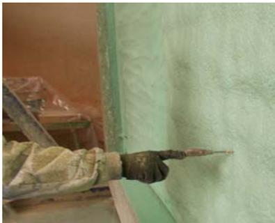
*Control del espesor del material en cámara intermedia.*
