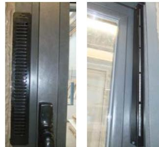
Ejemplo de un aireador colocado en perfilería de ventana (cara interior y exterior)
