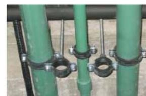
Los anclajes de las tuberías colectivas deben realizarse a paramentos de masa > 150 kg/m<sup>2</sup>, según el DB-HR, apartado 3.3.3.1.
