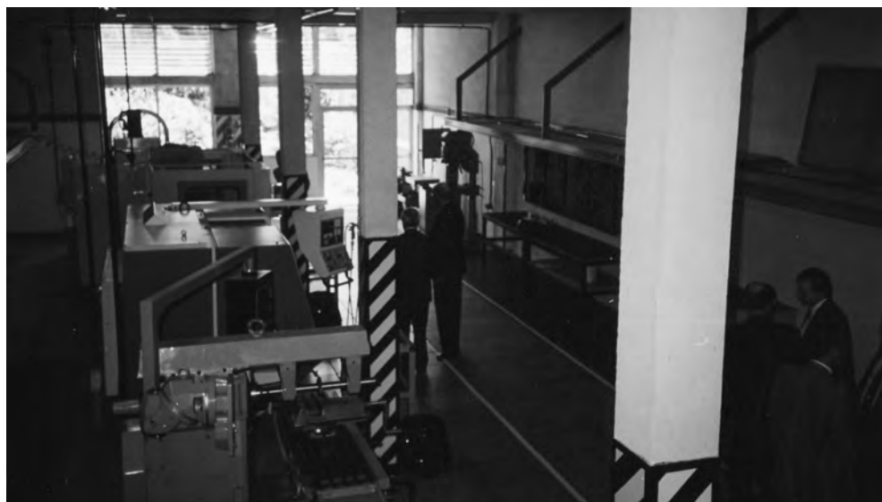
Instalaciones del IVACD. (Fuente: Arch. IL).
