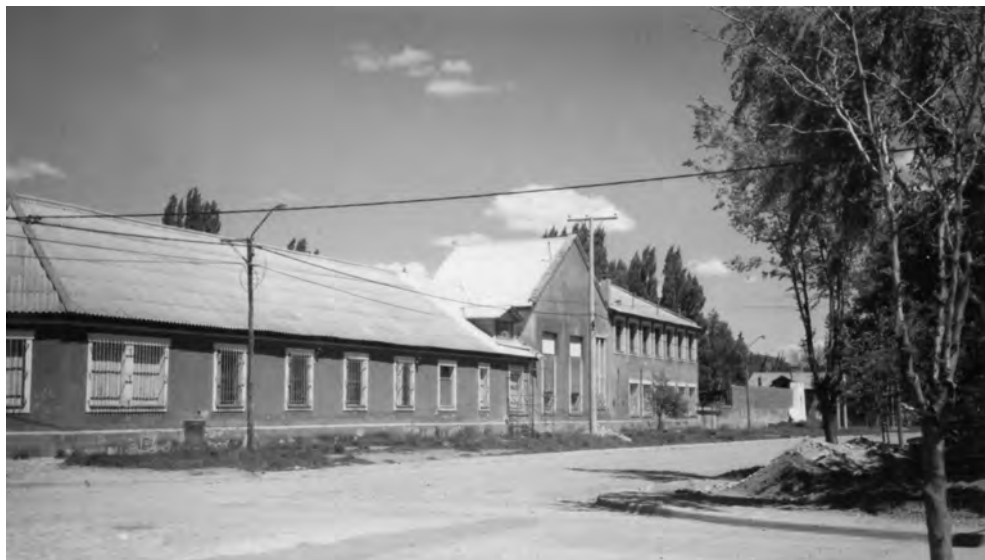
Vista general del Colegio Salesiano, de San Martín de los Andes. (Fuente: Arch. IL).
