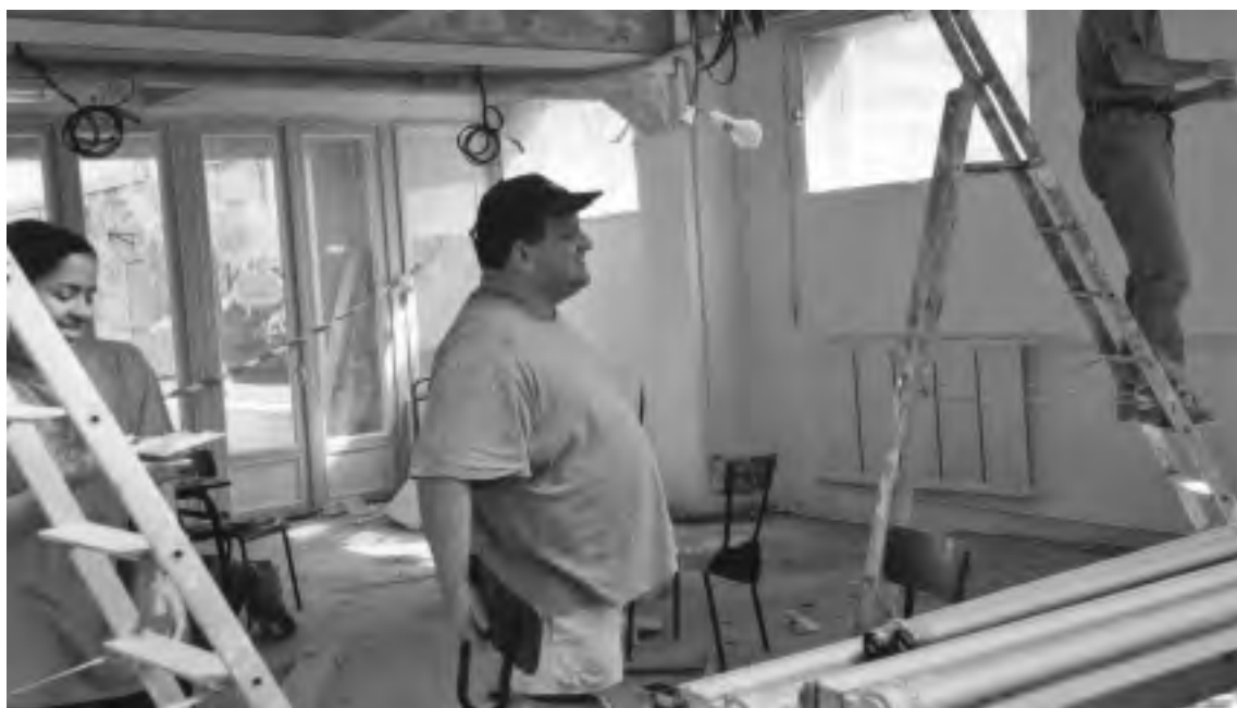
Des bénévoles lors des travaux des locaux à Saint-Ouen.
