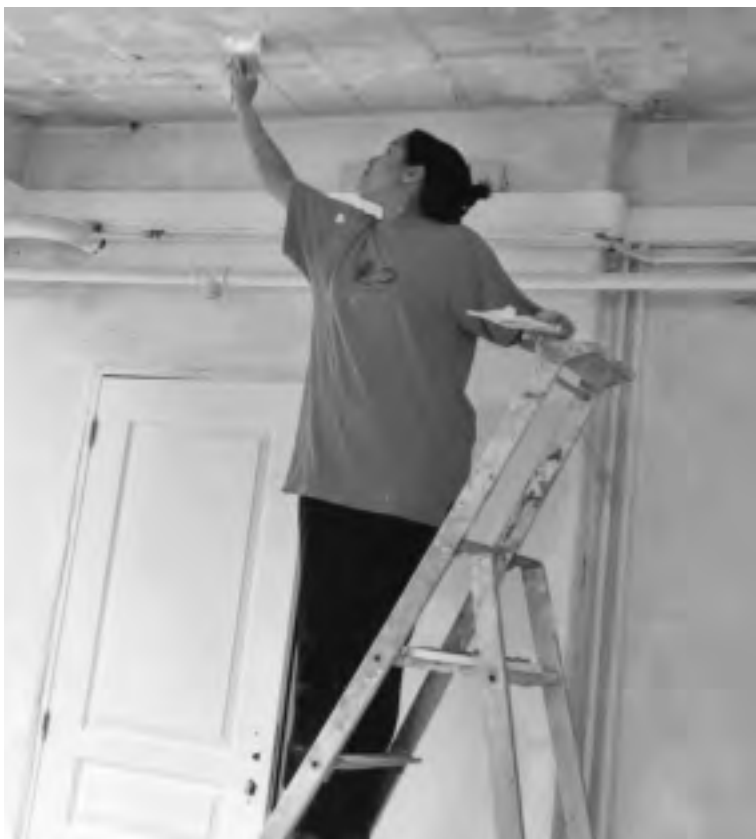
Des bénévoles lors des travaux des locaux à Saint-Ouen.
