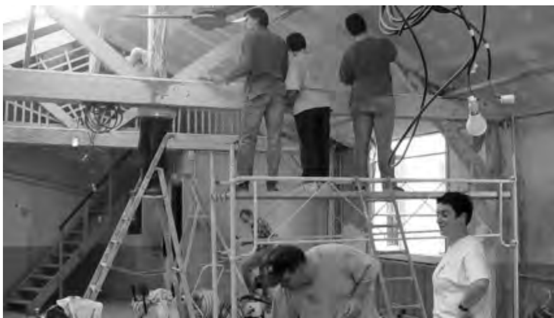
Les travaux, en mars 2003.
