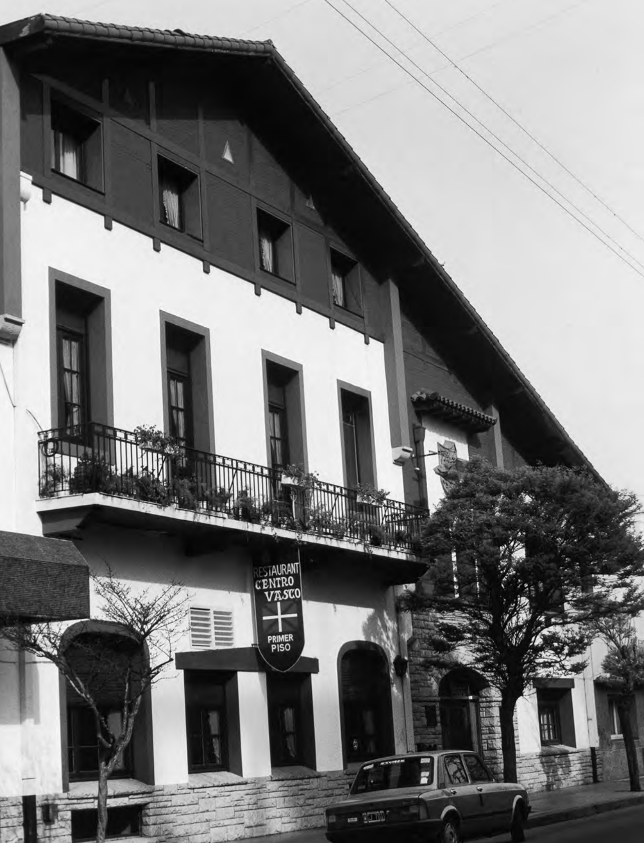
Estado actual de la fachada.
