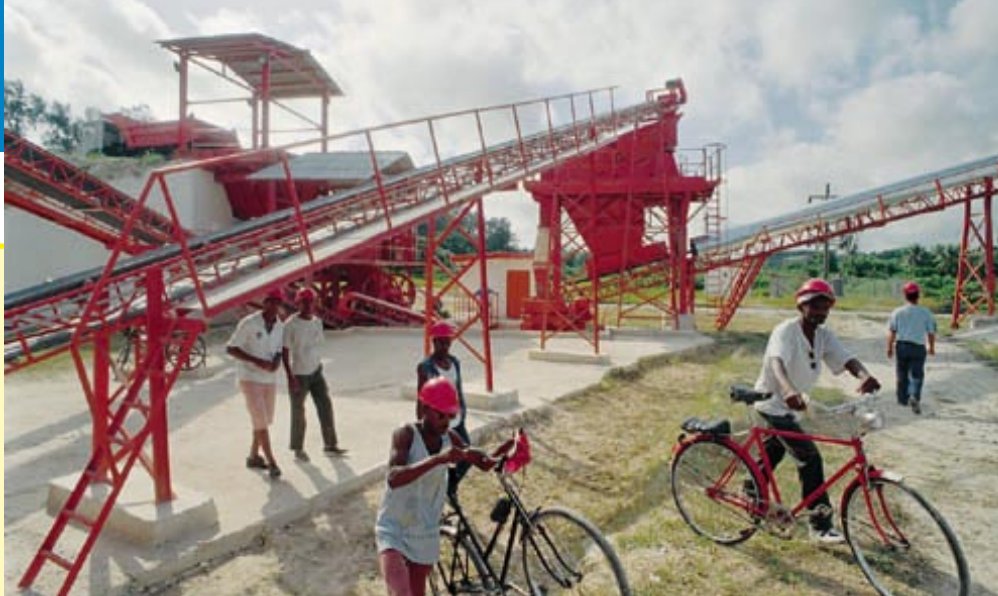
Planta de reciclaje de escombros creada con ayuda del Gobierno Vasco.
