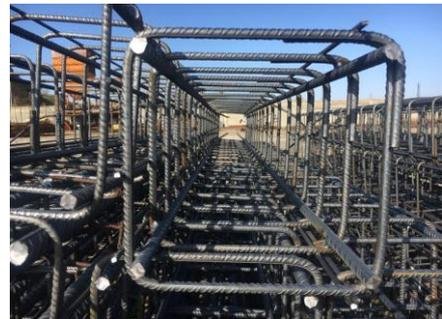
El artículo 87 de la EHE establece el control del acero para las armaduras pasivas, con los ensayos de comprobación a realizar durante la recepción del acero.
