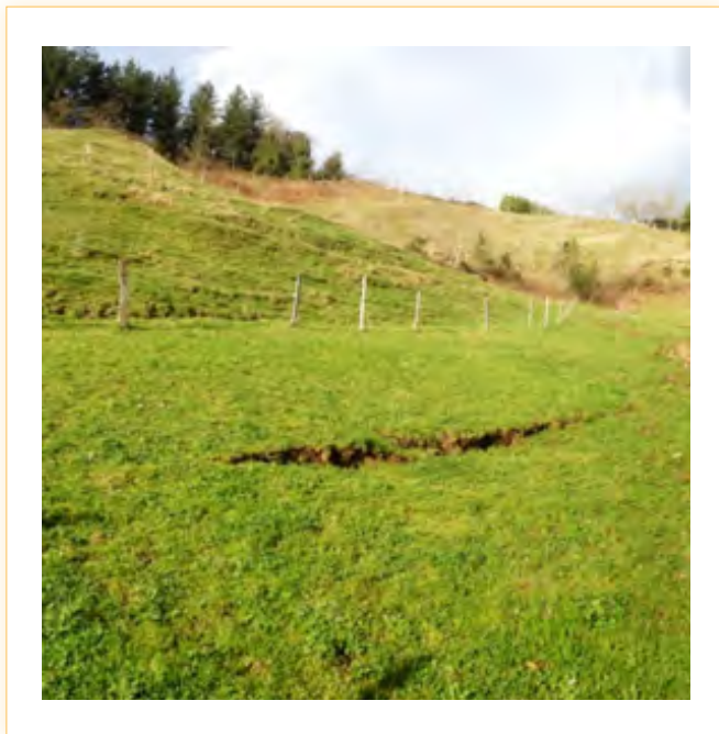
Imagen 17. Grieta de tracción en la parte superior de una ladera.
