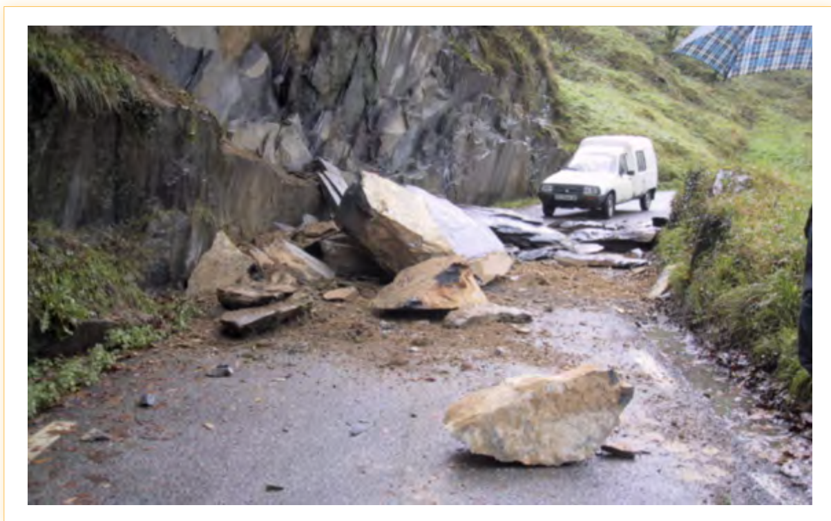
Imagen 25. Desprendimiento de bloques rocosos afectando a la carretera de acceso a un caserío.
