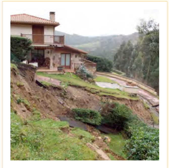
Imagen 8. Deslizamiento rotacional de suelos. En la imagen superior se observa el escarpe antes de que se produzca el movimiento final.
