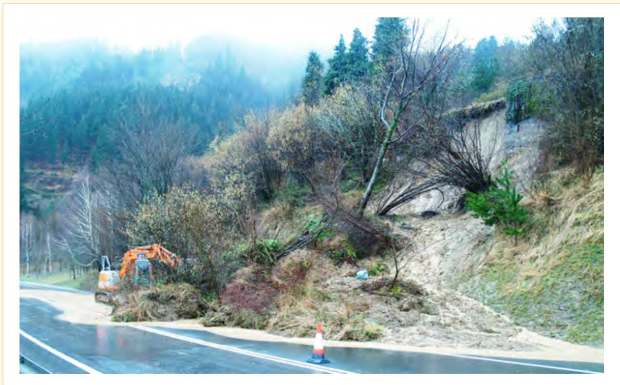
Imagen 6. Deslizamiento planar de suelos sobre un lecho de roca afectando a una carretera.
