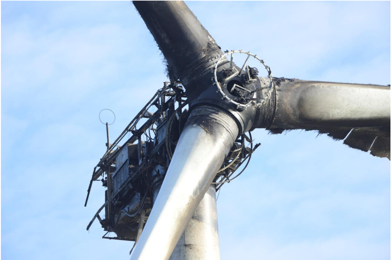
El 14 de diciembre de 2015 se incendió el aerogenerador A5.
