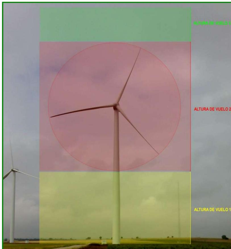
Imagen 3. Alturas de vuelo consideradas en aerogeneradores
