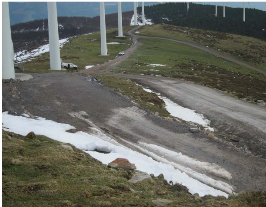
Foto 6: Vial de unión entre el aerogenerador 20 y el camino interno (18/02/2013)
