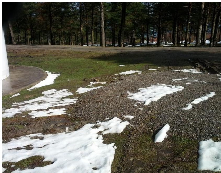
Foto 7: Plataforma del aerogenerador 12 (20/03/2013)
