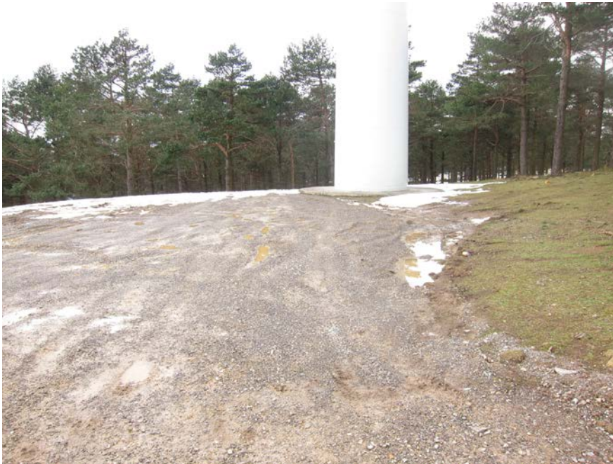
Foto 5: Plataforma del aerogenerador 10 (18/02/2013)
