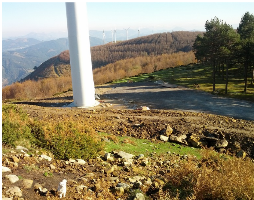
Foto 11: Entorno del aerogenerador 15 una vez finalizados los trabajos de montaje y desmontaje (28-11-2013).
