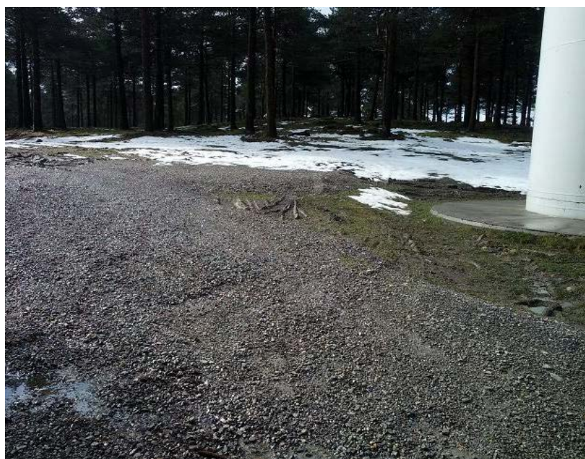
Foto 8: Plataforma del aerogenerador 11 (20/03/2013)
