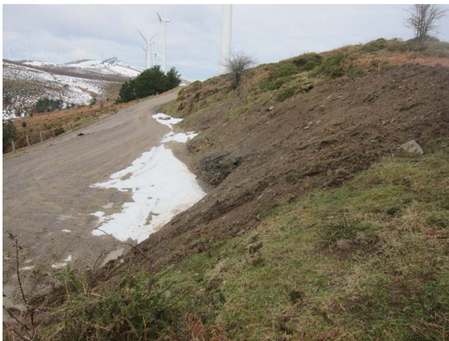
Foto 4: Plataforma del aerogenerador 2 (18/02/2013)
