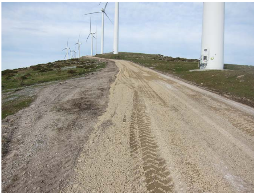
Foto 1: Ensanchamiento de pista acceso aerogenerador 20 (30-01-2013)
