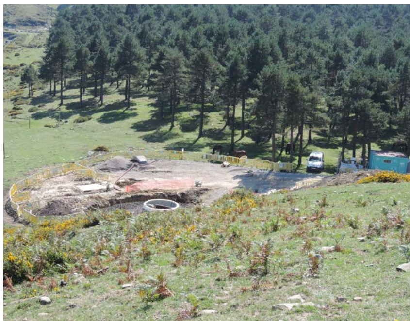
Foto 10: Desmontaje del aerogenerador 15 (24/09/2013)
