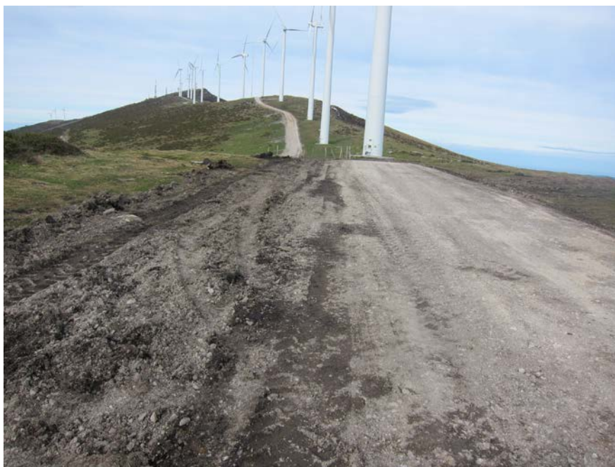
Foto 3: Ensanchamiento de pista entre aerogeneradores 16 y 17 (30-01-2013)
