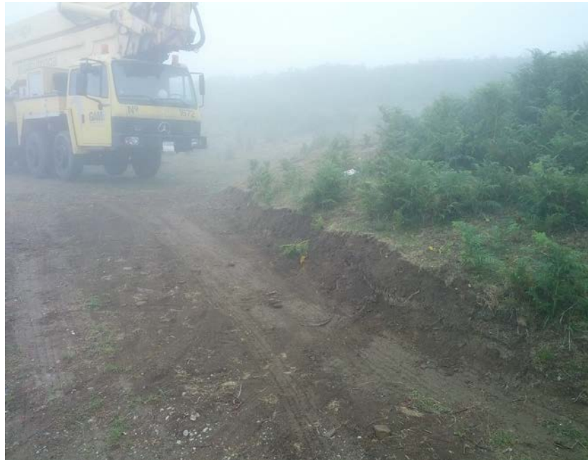
Foto 9: Trabajos de acondicionamiento para realizar tareas de mantenimiento en el aerogenerador 5 (06/08/2013).
