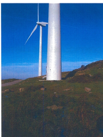
Depresión Inundable contigua al aerogenerador nº 39 de la fase II del parque eólico de Oiz un año después de finalizar las obras.
