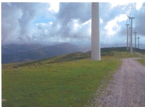
Estado de la cubierta vegetal en el entorno del aerogenerador nº 24 del parque eólico de Oiz.
