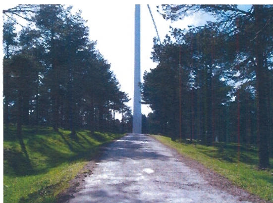
Integración de los caminos en el tramo comprendido entre los aerogeneradores nº 14 y 11 del parque eólico de Oiz.
