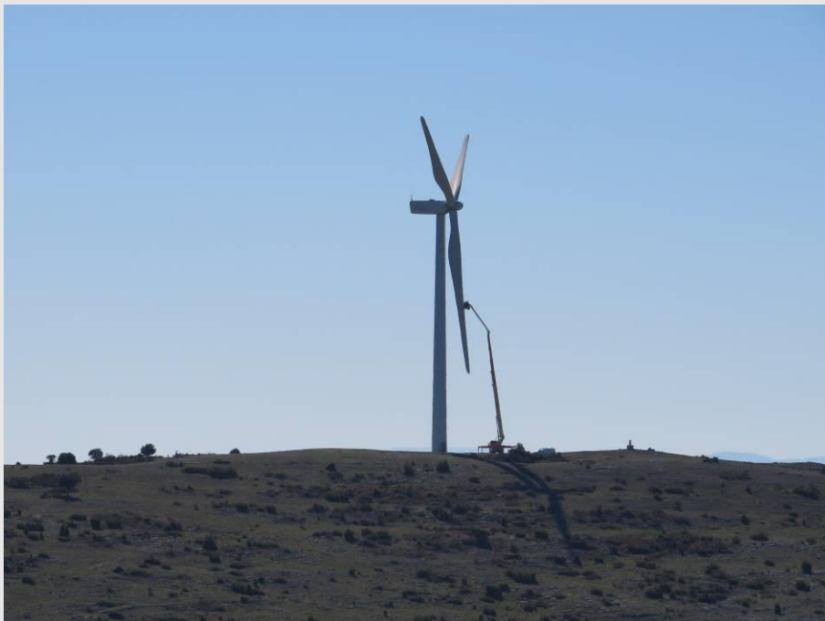
Fotografía 10. Técnicos realizando labores de mantenimiento en uno de los aerogeneradores.
