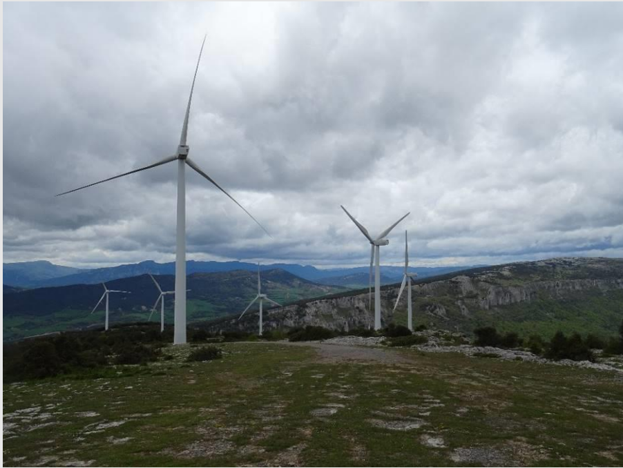
Fotografía 1. Vista general del parque eólico de Badaia.
