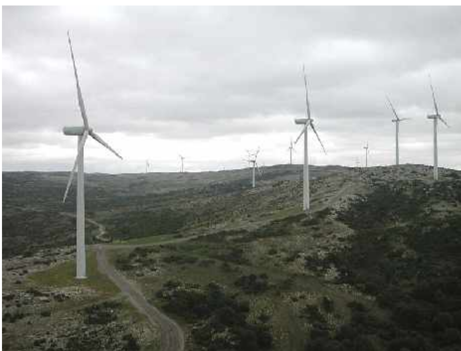
Vista del parque eólico de Badaia desde la barquilla del aerogenerador nº 16
