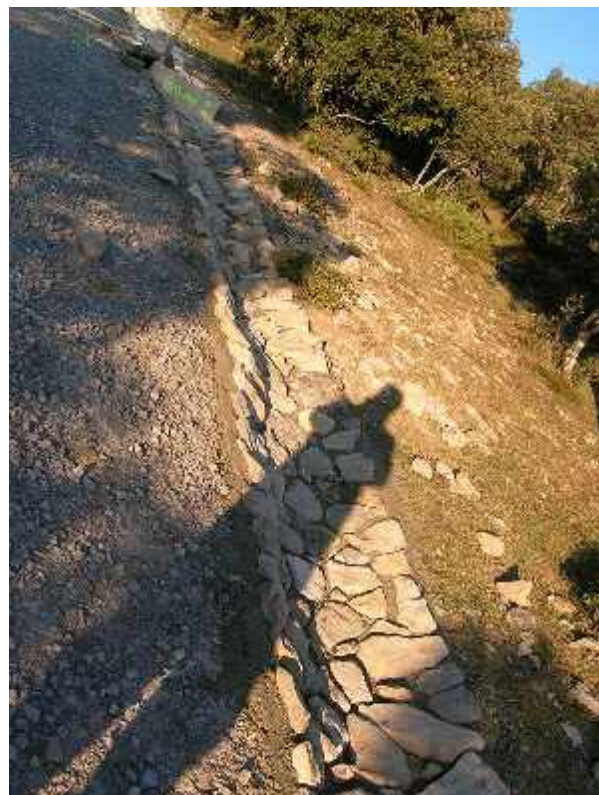
Cuneta de piedra ejecutada para evitar la erosión
