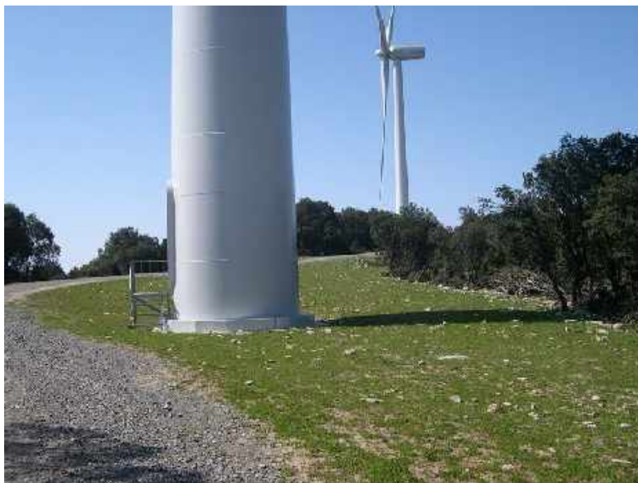
Ejemplo de plataforma revegetada, aerogenerador nº 17
