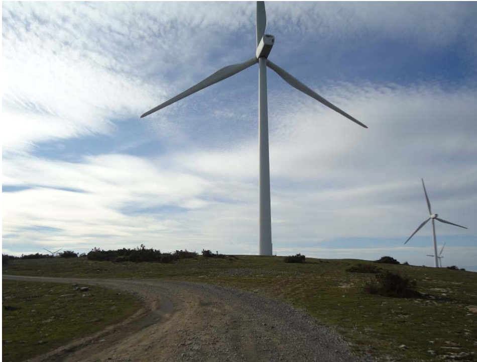
Foto 5: Rodadas de vehículos por fuera de las pistas habilitadas entre AG 20 y AG 21.
