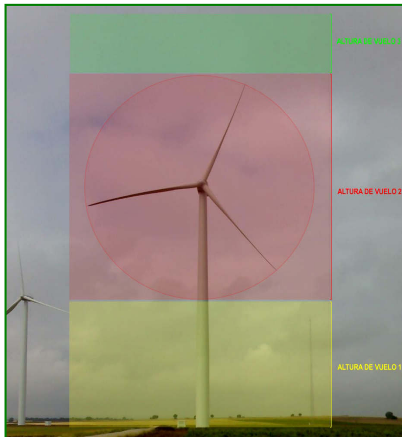
Imagen 3. Alturas de vuelo consideradas en aerogeneradores
