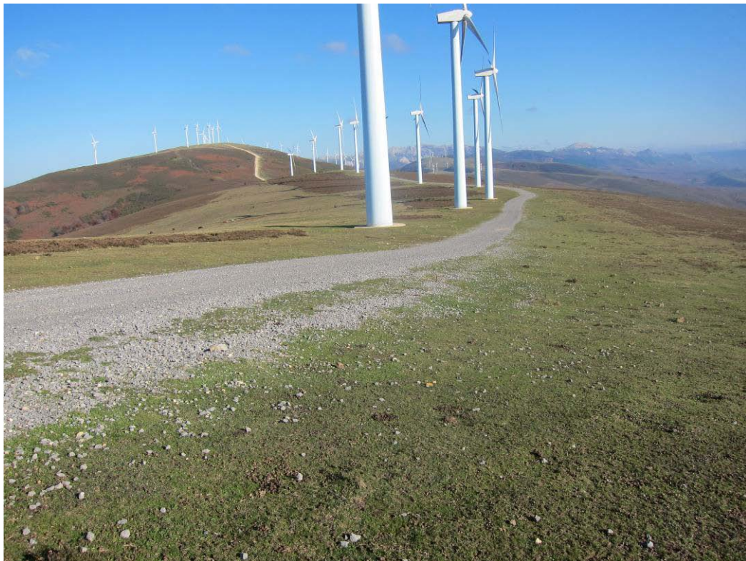
Foto 16: Arrastre de material entre aerogeneradores 5 y 7.
