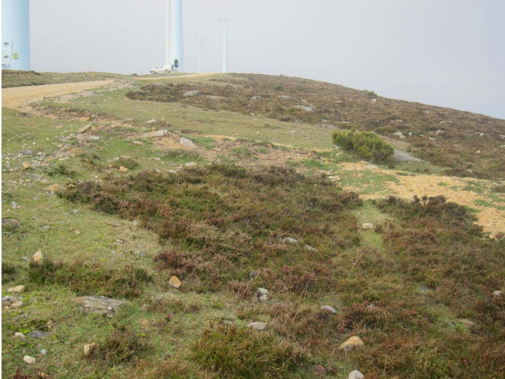
Foto 15: Arrastre de material entre aerogeneradores 32 y 33.
