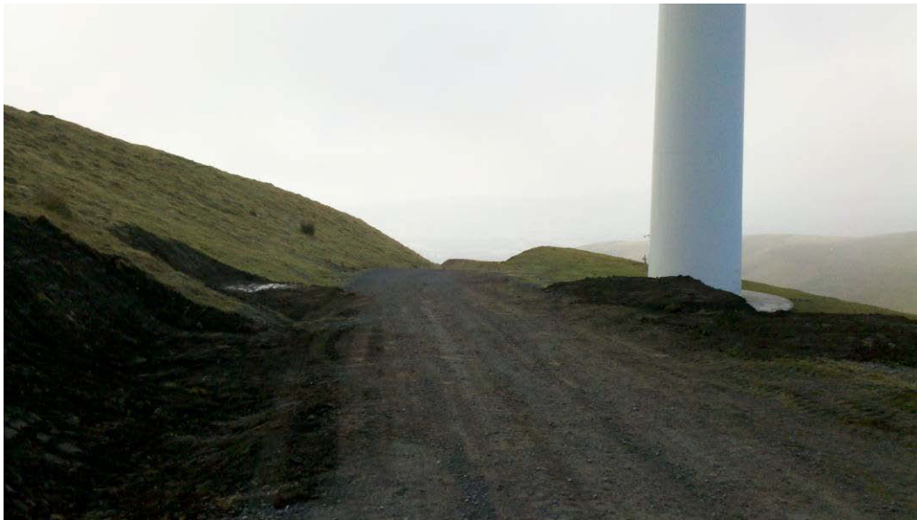
Foto 18: Realización de plataforma con material del talud junto al aerogenerador 52.
