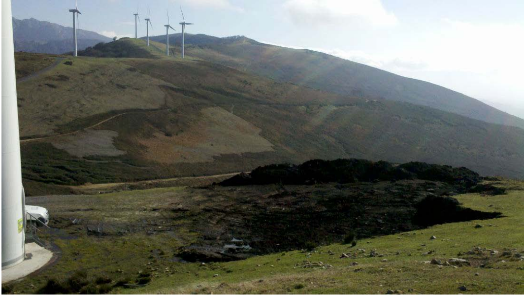
Foto 19: Retirada de material en las inmediaciones del aerogenerador 70
