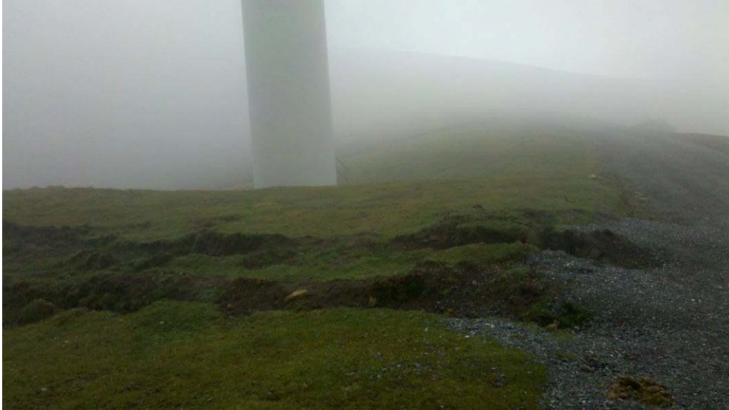
Foto 17: Roderas causadas por una grúa (aerogenerador 43).
