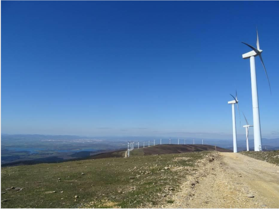
Fotografía 1. Vista general del parque eólico de Elgea-Urkilla.
