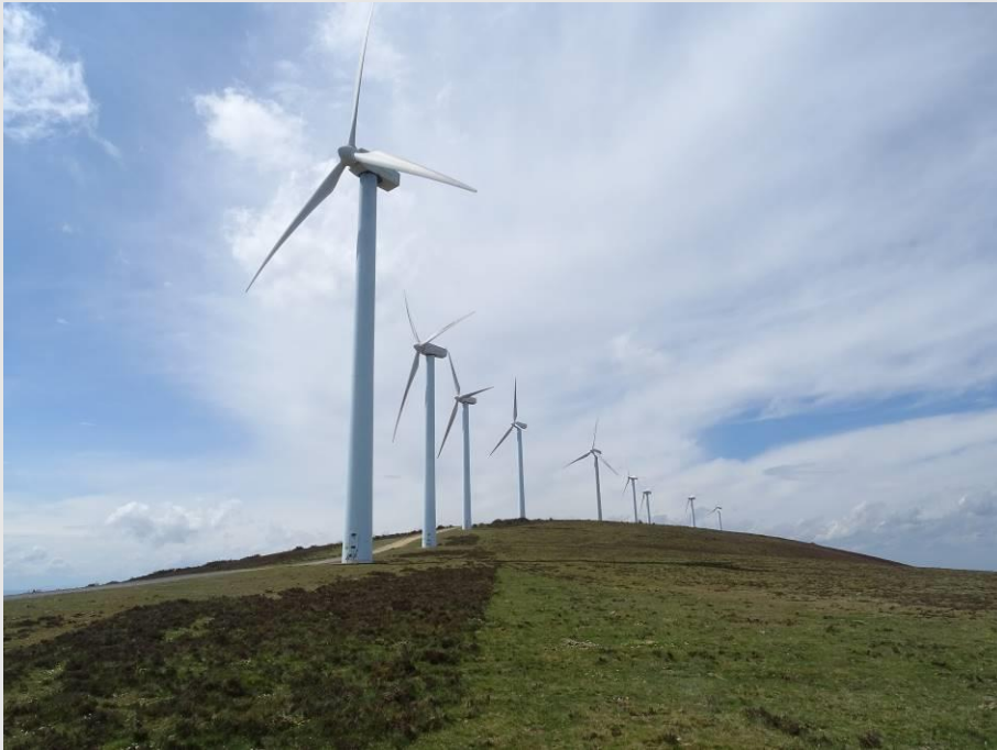
Fotografía 1. Vista general del parque eólico de Elgea-Urkilla.
