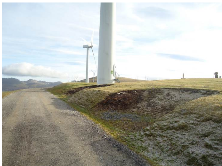
Fotos 2 y 3: Taludes y desmontes en el entorno de algunos aerogeneradores del Parque Eólico de Elgea – Urkilla.
