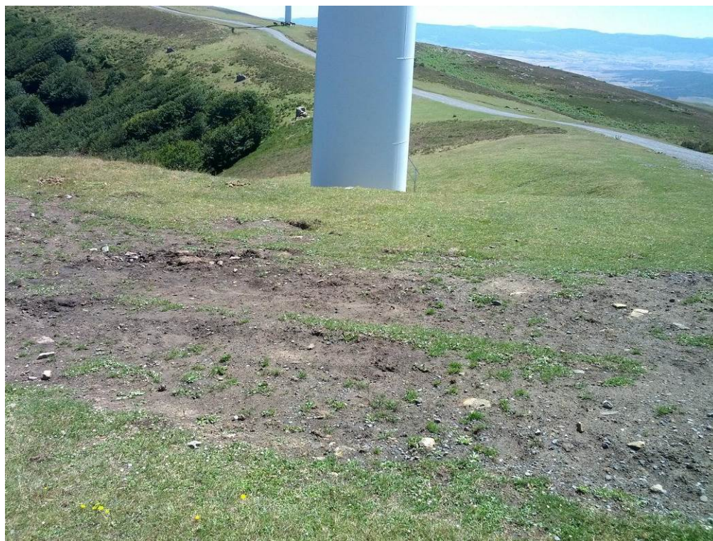
Foto 1: aporte de tierras a las rodadas de una grúa en el aerogenerador 43 (09/08/13).
