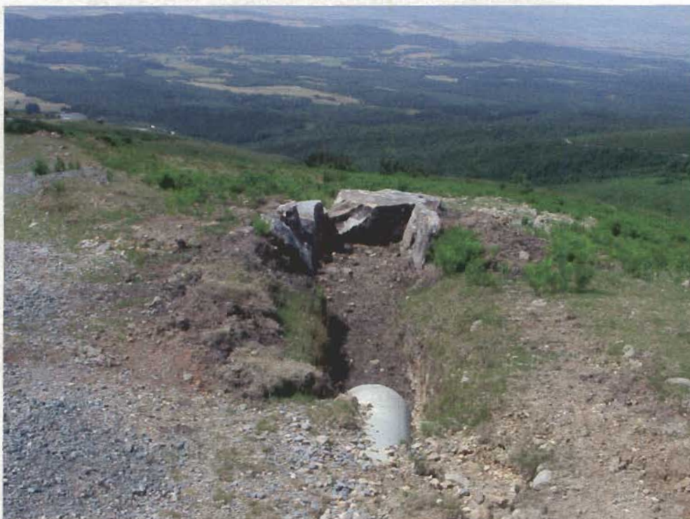
Deflectores colocados en 2005 a la salida de los drenes transversales.
