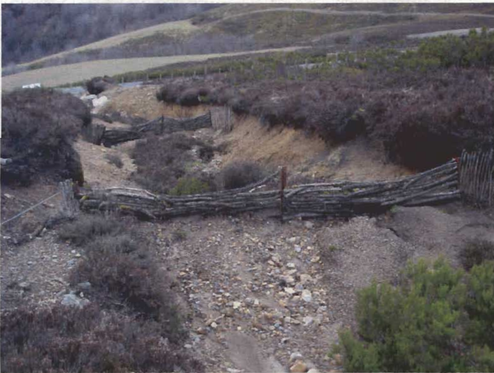
Barreras de contención de sólidos complementarias a los gaviones.
