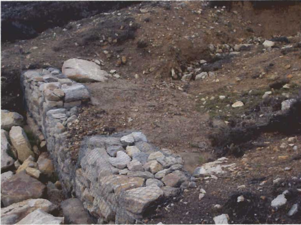
Materiales retenidos por los gaviones colocados en verano de 2003 en una cárcava de la Sierra de Urkilla, tres años después de su colocación.
