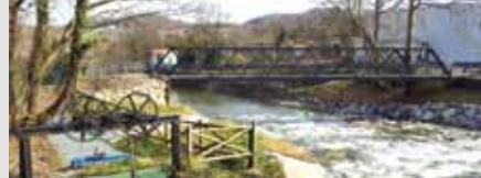
La compuerta que alimenta el cauce del canal de Fandería y la rampa que facilita el paso de peces.
