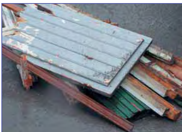
Fig 13: Separación de Elementos de Carpintería.
