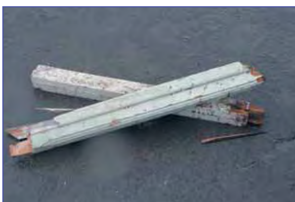
Fig 21: Elemento de carpintería (premarco pintado de blanco).
