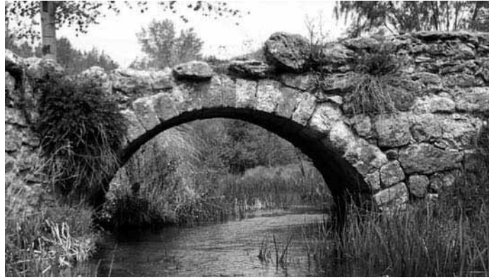
Zubi erromatarra. Arkua osatzen duten harriek falka forma dute. Arkuaren pisua alboetara lekualdatzen da konpresioan, ibaiko ertzak tentsioan daude.
