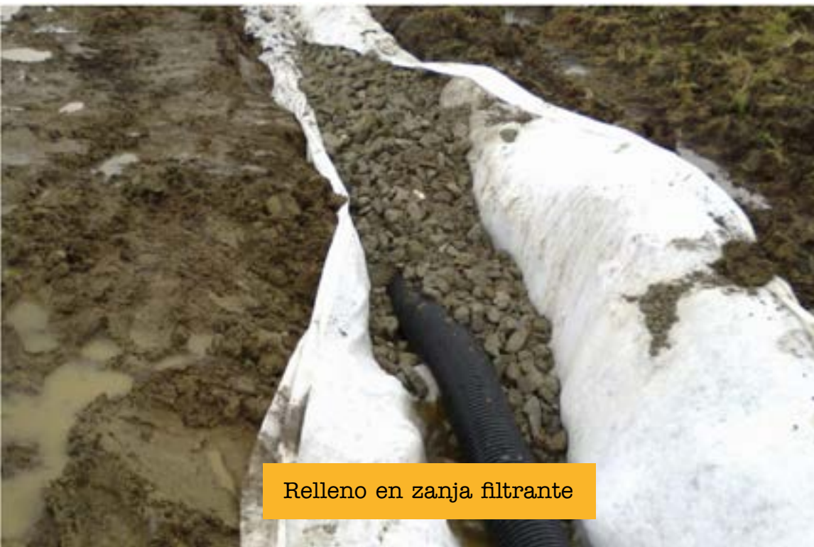
Rellenos en zanjas y zona de vial
