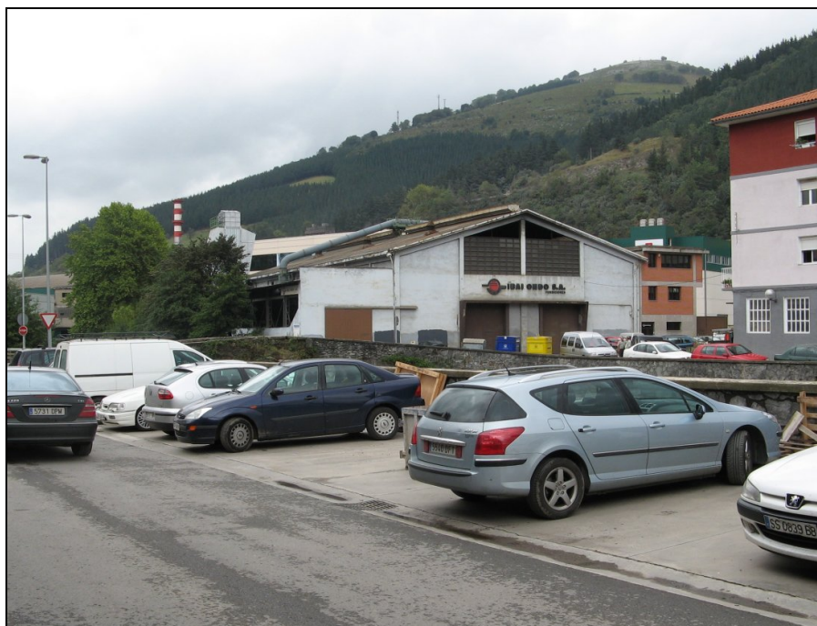
Figura A.5. – Fundiciones Ibaiondo. Se sitúa dentro del Polígono Landeta al sureste (SE) del núcleo urbano. Recientemente (verano 2006), ha instalado un sistema de captación y filtrado de las emisiones de su actividad
