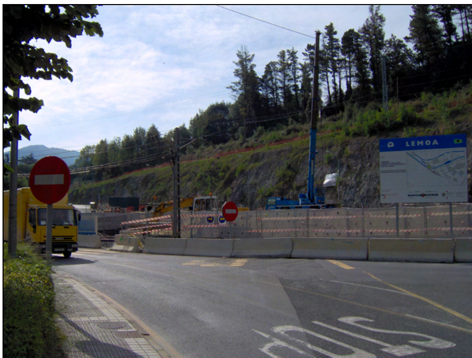
Figura A.10. – Obras de soterramiento del tren junto al antiguo paso a nivel de Lemona
