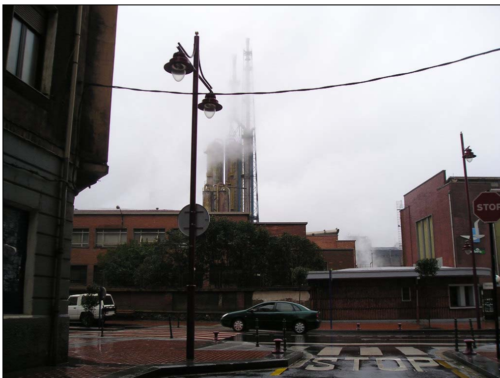
Figura F15. - Sefanitro-Fertiberia situada próximo al núcleo de población principal de Barakaldo al sureste (SE) de la estación de medida de Barakaldo
