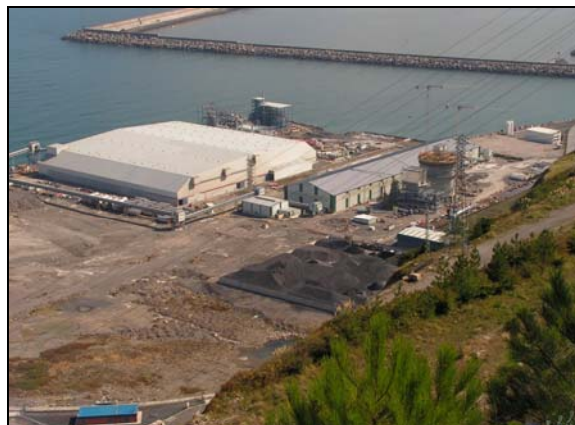
Figura F1. - Industrias instaladas (BBE) o en fase de instalación en el Puerto Exterior de Bilbao (Moyresa, Atlántica)
