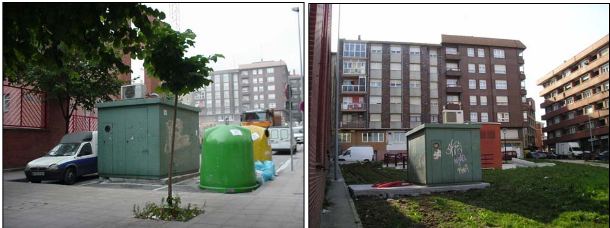
Figura 6.41. - Ubicación de la estación de calidad del aire de Barakaldo . Izquierda: Durante las obras (Julio 2003); Derecha: Posterior a las obras
