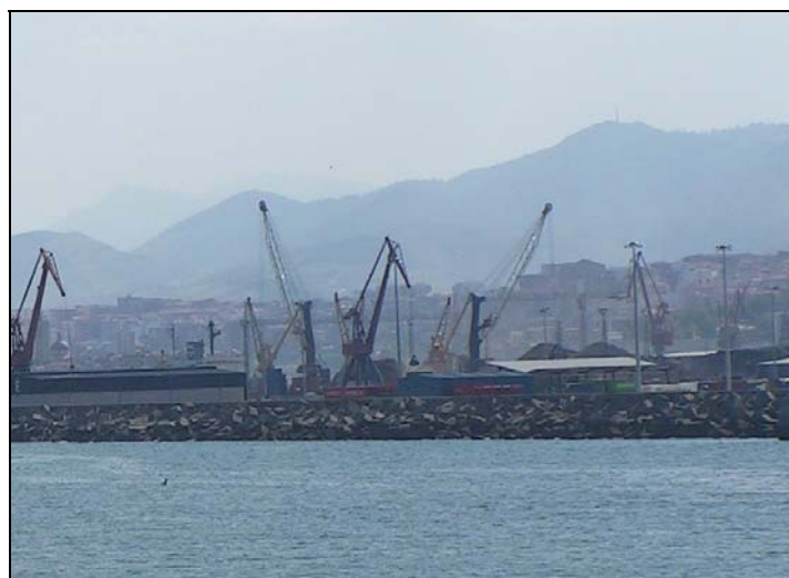
Figura F3. - Zona de descarga de chatarra y gran trasiego de material (contenedores) al sureste (SE) del barrio del Puerto de Zierbena.
