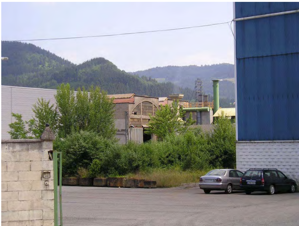
Figura A.5. - Fundiciones Gelma, S.A. Situada al este (E), próximo al casco urbano de Arrasate-Mondragon
